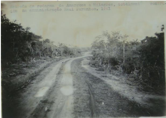
Figura 21 – Fotografias das obras consideradas prioritárias nos governos em Amargosa: as estradas e o embelezamento urbano. Na foto, tem-se a estrada aberta de Amargosa a Milagres
