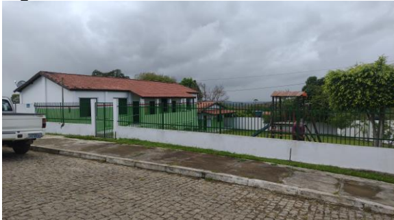
Figura 60 – Foto da Escola Eraldo Tinoco, situada no Alto Seco, com infraestrutura razoável.
