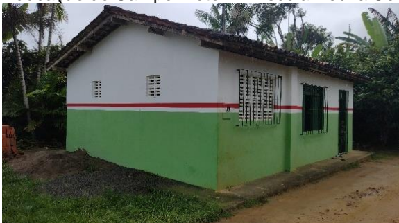
Figura 59 – Exemplo de escolas construídas sem áreas para desenvolver atividades formativas na Educação do Campo. Foto 2 – Escola Neuza Cerqueira, situada na Comunidade do Ribeirão do Cupido
