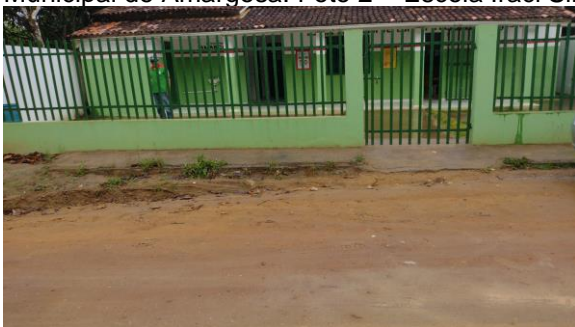
Figura 42 – Escolas construídas pela EMATERBA atualmente fazem parte do sistema de educação Municipal de Amargosa. Foto 2 – Escola Iraci Silva, situada na Comunidade do Córrego
