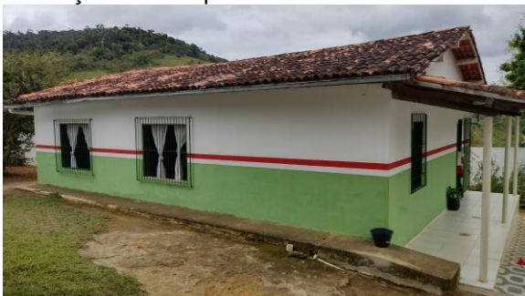
Figura 58 – Exemplo de escolas construídas sem áreas para desenvolver atividades formativas na Educação do Campo. Foto 1 – Escola Humberto e Elmano Castro, situada na Fazenda Timbó
