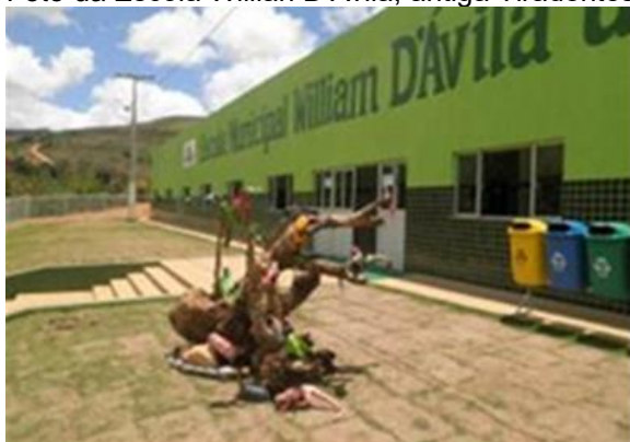
Figura 52 – Escolas construídas ou totalmente reformadas no campo na gestão de Valmir Sampaio. Foto da Escola Willian D’Avila, antiga Tiradentes, no Timbó Grande.
