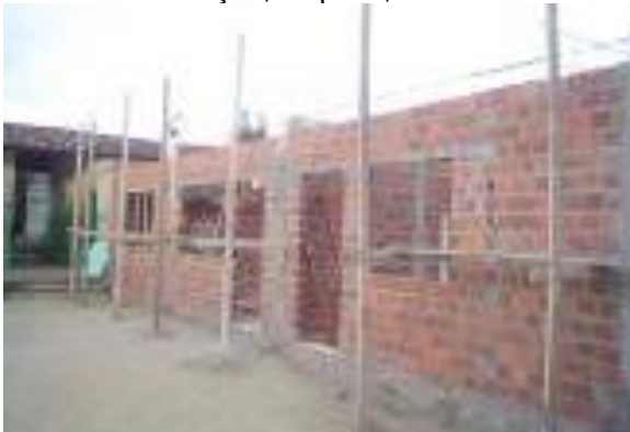
Figura 55 – Escolas construídas ou totalmente reformadas no campo na gestão de Valmir Sampaio. Foto 4 – construção, à época, da Escola Julio Pinheiro, em Corta-mão.
