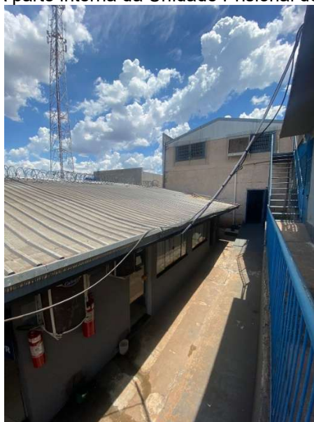
Figura 3 - A parte interna da Unidade Prisional de Toledo-PR
