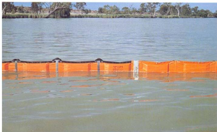
Fig. 22: Barreras de contención (Fuente: Chorus & Bartram, 1999)
