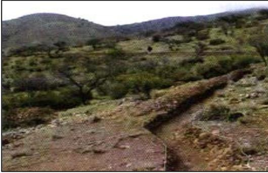
Fig. 9. Canal de Desviación: Obra de recuperación de suelos, manual o mecanizada, que se sitúa preferentemente en la parte superior o media de la ladera para capturar la escorrentía procedente de cotas superiores.
