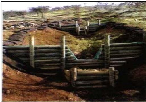
Fig 11 Dique de Postes: obra para el control de cárcavas y de cursos de agua secundarios, generalmente temporales, tales como arroyos y quebradas, que actúa por resistencia mecánica.
