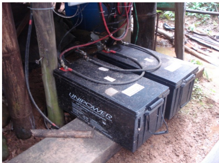
Figura 26: Baterias para armazenamento de energia
