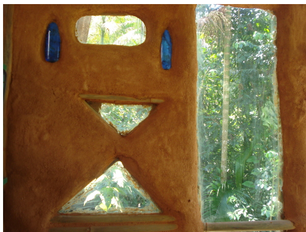
Figura 22: Paredes de pau-a-pique com vidros e garrafas
