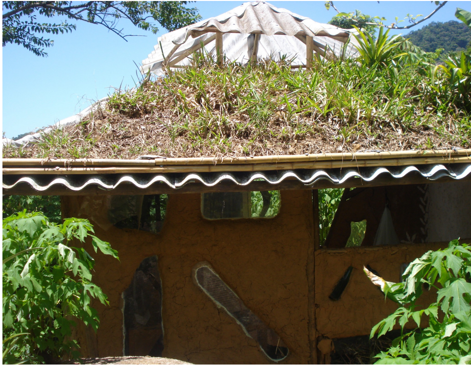
Figura 19. Dormitório de morador no IPEMA: demonstração das técnicas das paredes, do telhado verde e da abertura no telhado
