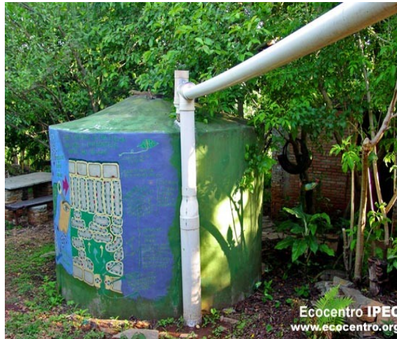
Figura 11. Modelo de cisterna construído no IPEC
