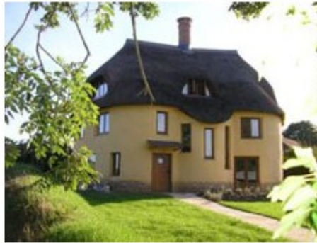
Figura 07. Casa com 3 pavimentos em Cob
