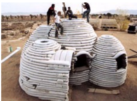
Processo construtivo das abóbodas
