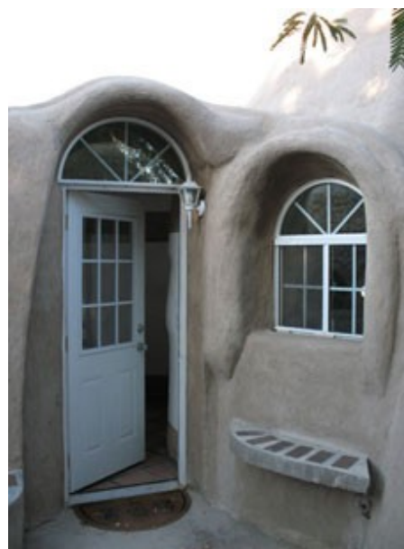
Entrada de Edificação em Super-Adobe
