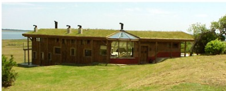
Figura 04 : Casa construída em adobe com telhado verde – Uruguai
